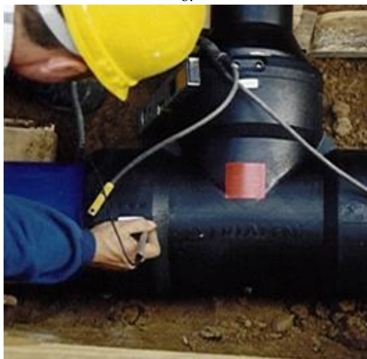
Obr. 6.2 Svařování potrubního systému v terénu
