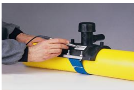
Obr. 5.18 Načtení parametrů z čárového kódu
