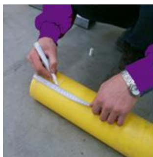
Obr. 5.4 Označení konce trubky
