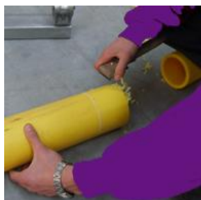
Obr. 5.5 Oškrábání konce trubky
