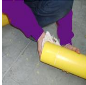
Obr. 5.6 Očištění trubky
