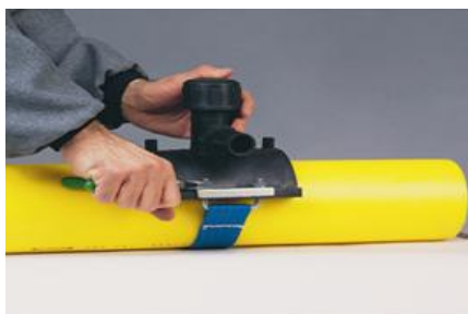
Obr. 5.17 Namontování sedla na trubku
