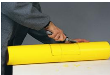
Obr. 5.15 Oškrábání místa svařování
