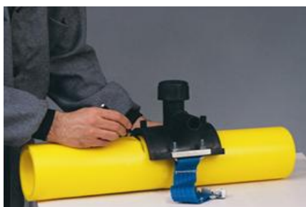
Obr. 5.14 Označení oblasti svařování
