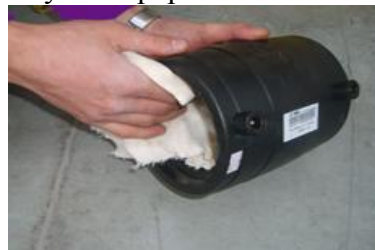
Obr. 5.7 Očištění tvarovky
